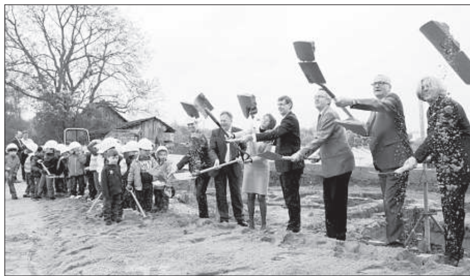
Auftakt für den neuen Betriebskindergarten des Berufsbildungswerks Waiblingen: der erste Spatenstich am Donnerstag, 2. Mai 2013. Unser Bild zeigt von links nach rechts: Projektleiter Oliver Conrad, Rainer Gaag, Geschäftsführer des BBW; Heiderose Maaß, Vorstand der Diakonie Stetten; Vorstandsvorsitzender Rainer Hinzen, Oberbürgermeister Andreas Hesky, Volker Stauch von „Star Care“ sowie Architekt Martin Rau. Foto: Diakonie Stetten
