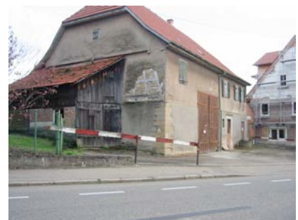
Leerstehende Gebäude entlang der Neustädter Hauptstraße
