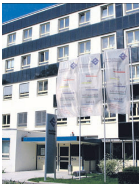
Die Stadtwerke Waiblingen sind stolz darauf, alle Leistungen aus einer Hand bieten zu können. Foto: David
