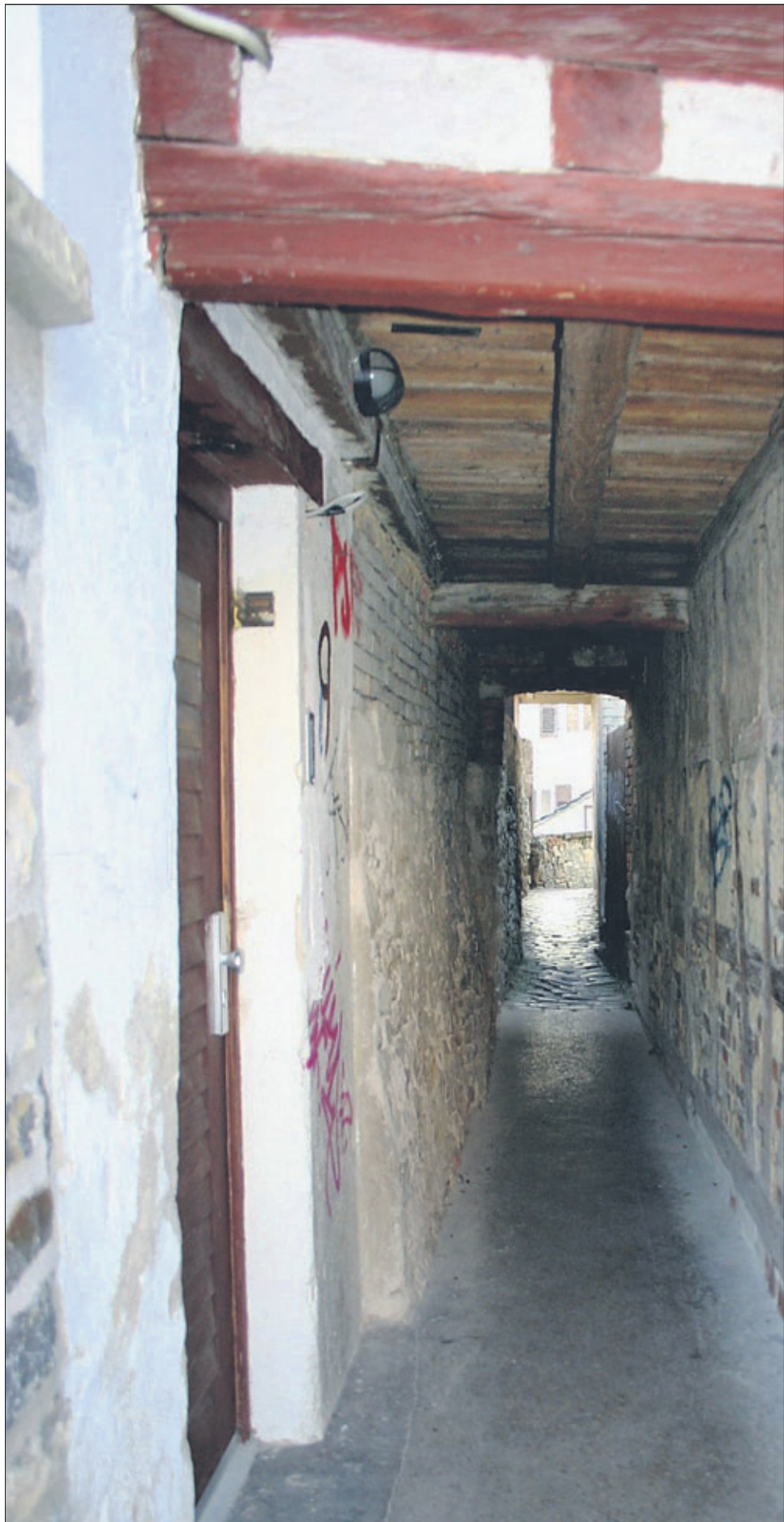
Die Stadtmauer und der Wehgang sollen in den kommenden Jahren saniert werden. Etwa 750 Meter sind noch erhalten, die da, wo es erforderlich ist, in vier Bauabschnitten wieder in Stand gesetzt werden sollen. Das Bild zeigt einen Blick in den Mauergang aus Richtung Beinsteiner Torturm. Erste Arbeiten sind an der Stadtmauer im Bereich Hadergasse notwendig. Foto: Redmann
