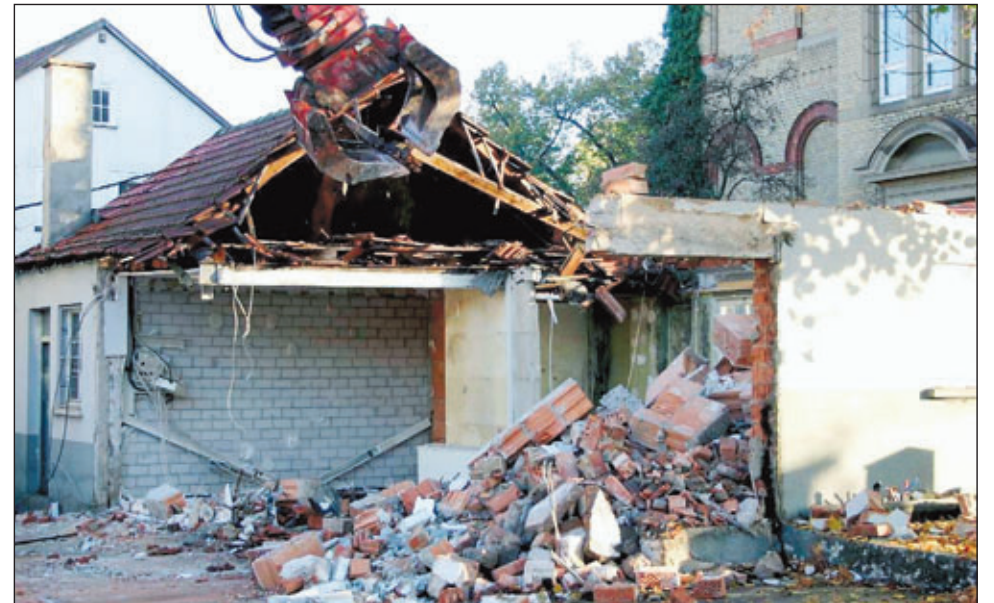
Die Abbrucharbeiten am Alten Postplatz haben an der Karolingerschule begonnen ...
