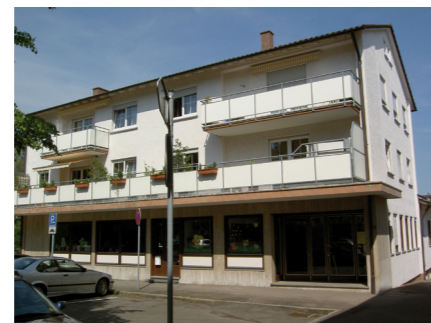
Danziger Platz 13 vor und nach der Modernisierung
