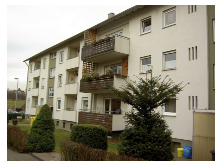
Gänsäckerstraße 1 und 3 vor und nach der Modernisierung
